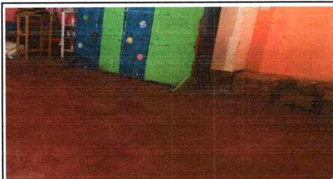
Foto 9: Cambio de piso en aulas por deterioro en el primer nivel de la escuela.
