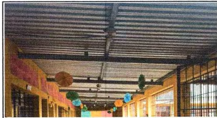
Foto 4: Instalación de cielo falso en el corredor del segundo nivel del Centro Educativo, para disminuir el calor en esta área.
