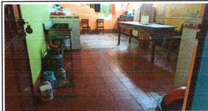
Foto 11: Cambio de piso en la cocina, por piso antideslizante.
