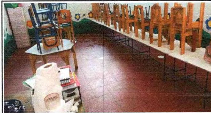
Foto 10: Cambio de piso en aulas por deterioro en el primer nivel de la escuela.
